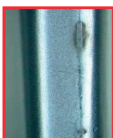
Coroziune de contact
