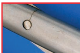
Fisură fină în vecinătatea articulației foarfecii
